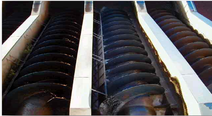
Photo2 : Opération de relevage dans la station de prétraitement
