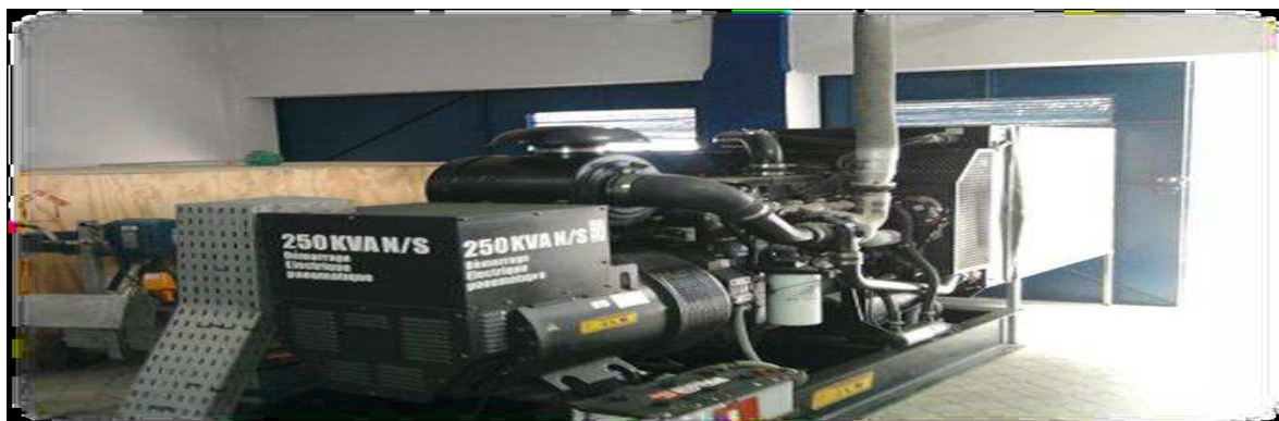
FIGURE 5: GROUPE ELECTROGENE DE 250 KVA
