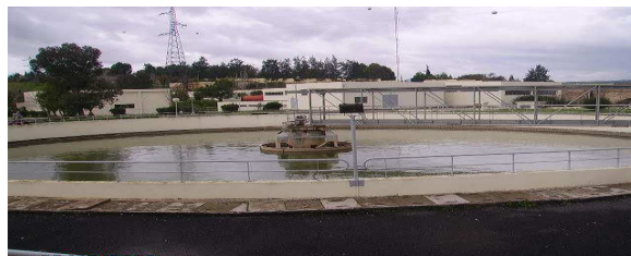
Figure 5: opération de débouage dans la station de prétraitement
