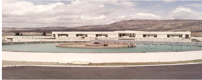
Figure 5: opération de décantation dans la station de traitement
