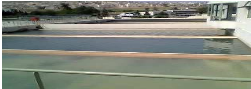
Figure 6: opération de filtration sur sable dans la station de traitement
