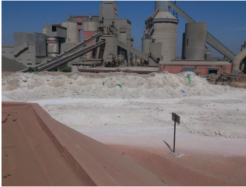
Figure9:partie de la carrière de Holcim
