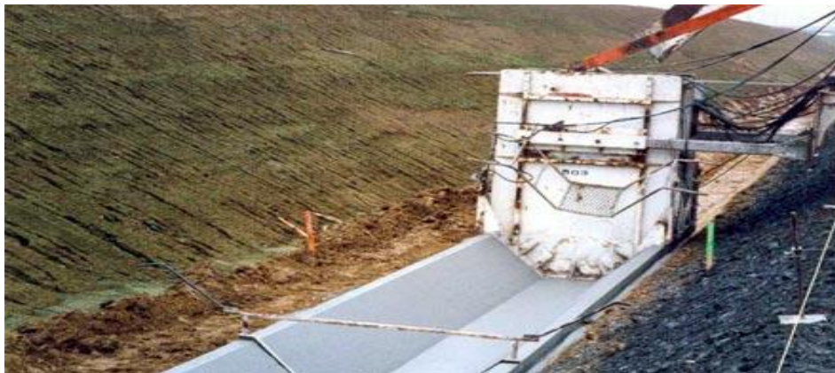
Figure 24 : Fossé en béton
