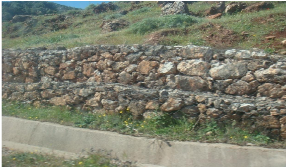
Figure 25 : Technique de soutènement "mur en maçonnerie"
