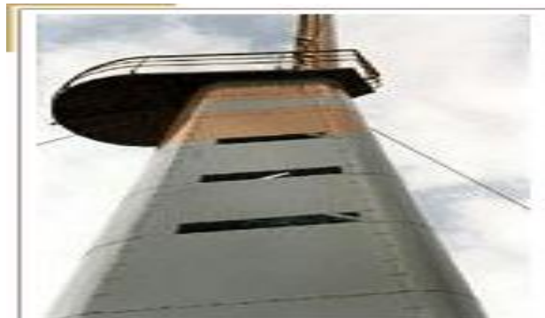
Figure N°6 : Mât métallique de 25m de haut
