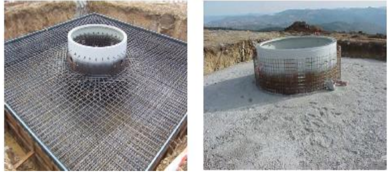
Figure 26 : Armature et Bétonnage de la fondation
