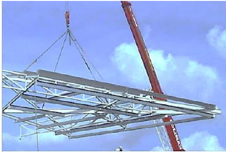
Figure II.6 Eléments assemblés au sol
