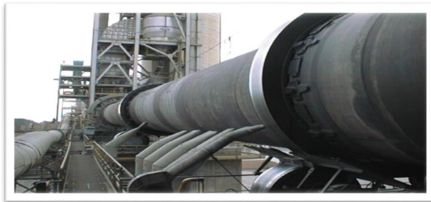
Figure 4: Image du four de cuisson du clinker utilisé par Holcim
