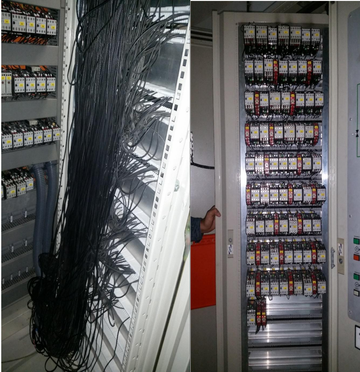
Système de relayage- logique câblée
