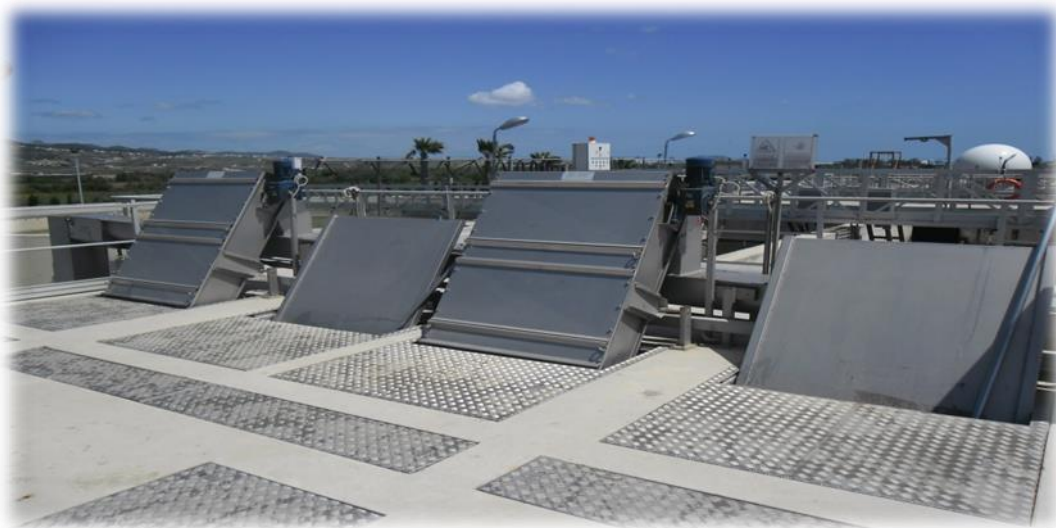
Figure 7 : Dégrilleurs
