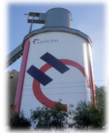
FIGURE 10 : SILO DE STOCKAGE DU CLINKER
