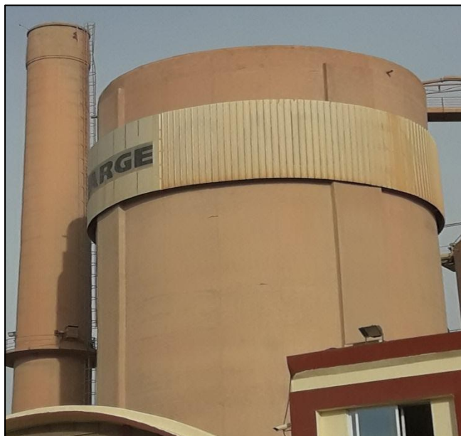
Figure 8 : Silo d'homogénéisation de 7 500 tonnes
