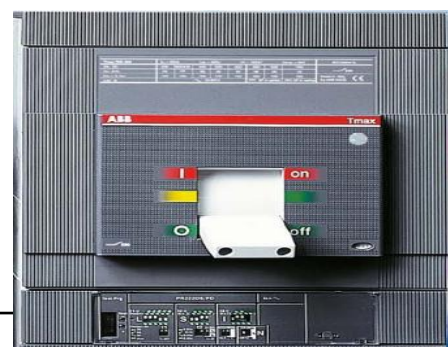
FIGURE 8 :DISJONCTEUR GENERAL
