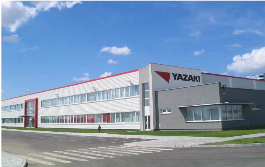
Figure 3 : L'usine de YAZAKI MOROCCO MEKNES (YMM)
