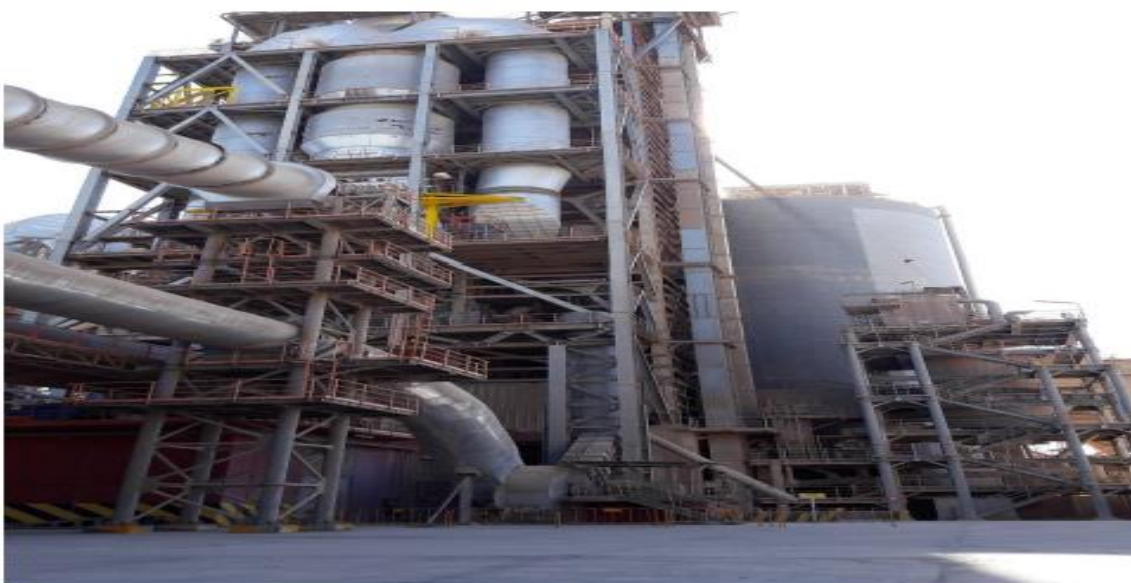
Figure 6: Tour de préchauffage de la cimenterie de Fès
