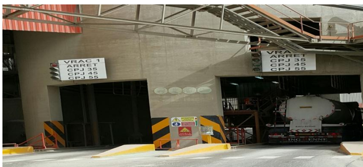
Figure11 :Expédition à travers des wagons citernes
