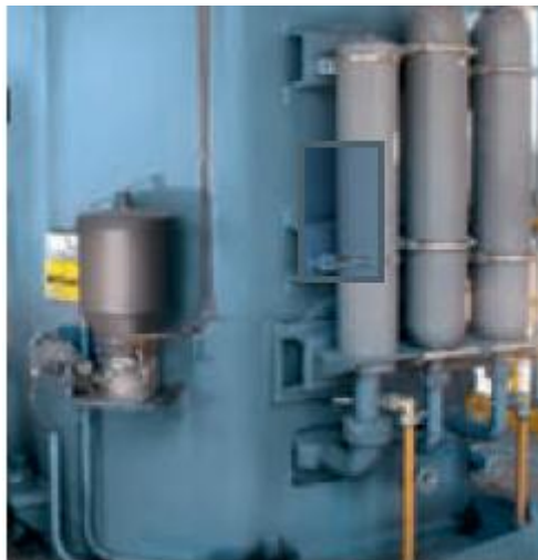
Figure 15 : Ressorts hydropneumatiques
