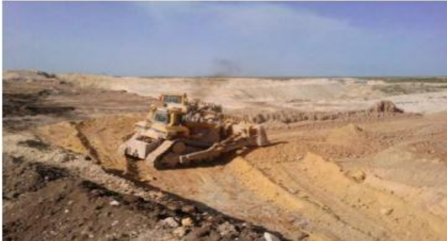
Figure Erreur ! Il n'y a pas de texte répondant à ce style dans ce document..6 : Méthode de décapage d'un bulldozer.
