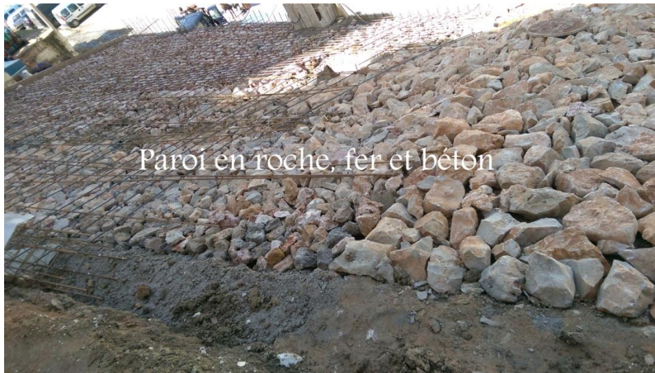
Figure 60 : Paroi rocheuse s'opposant aux mouvements de terrains
