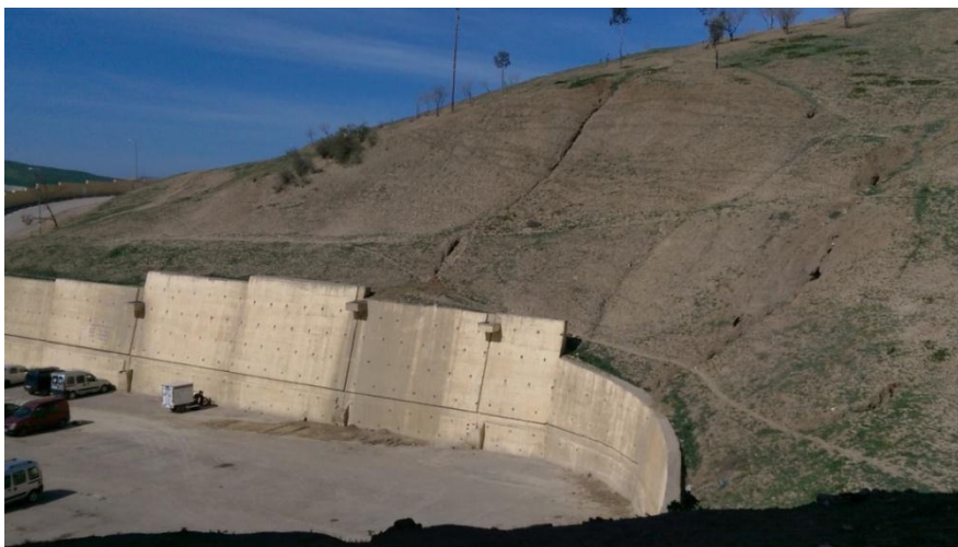
Figure 59 : Mur de soutènement
