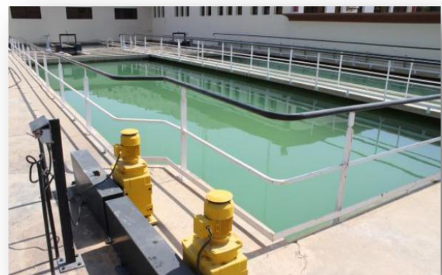
Figure 8 : Bassins décanteurs 8
