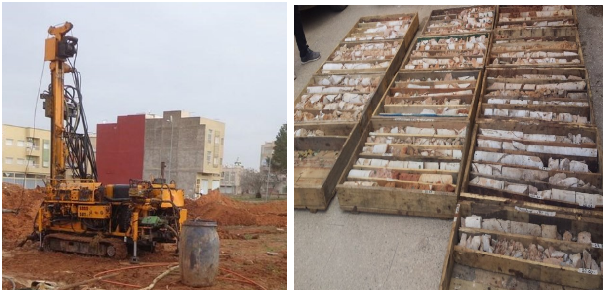
Figure 27 : La sondeuse et les carottes.
