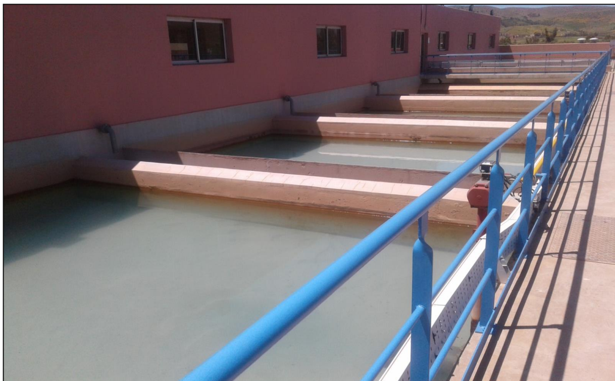
Figure 7 : Lits de sable (Filtration)
