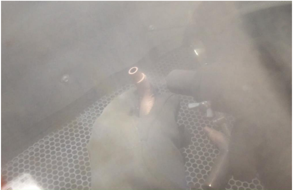
Figure 50: Allonge en cours de sablage
