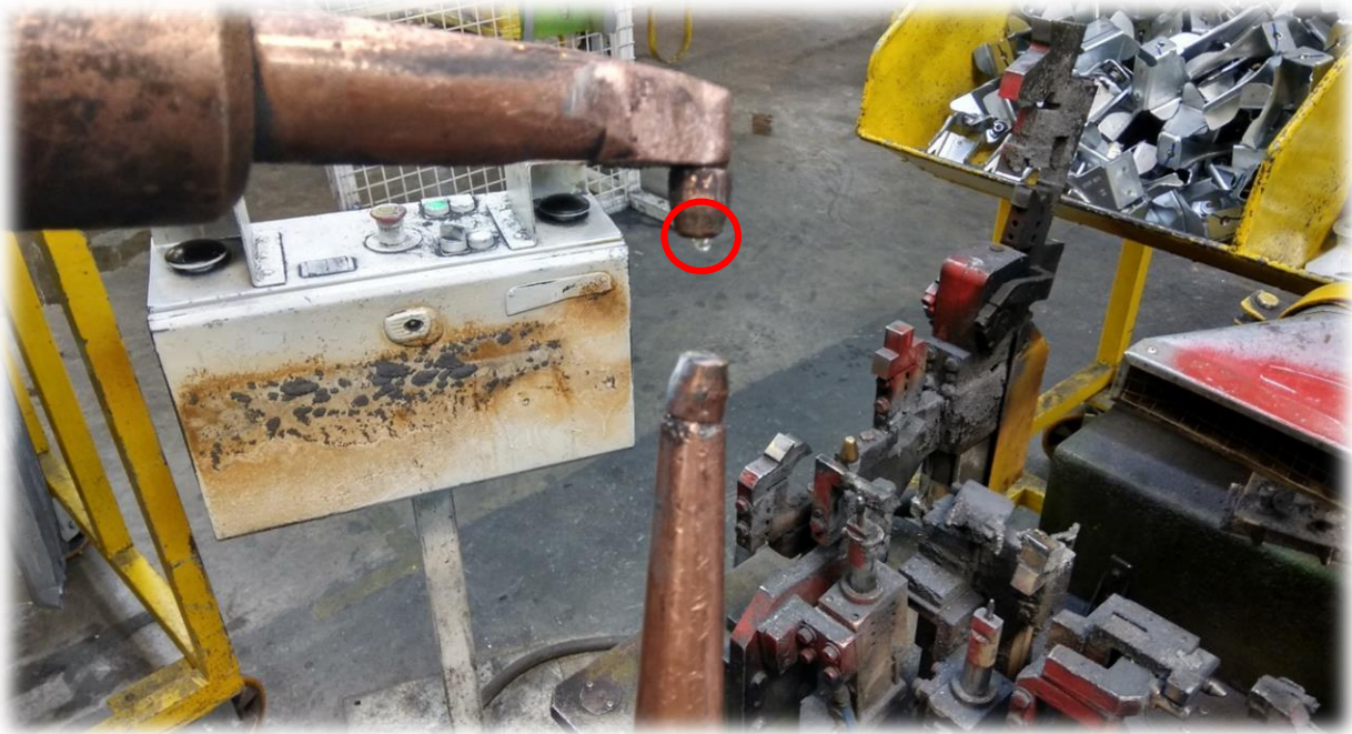
Figure 28: Fuite d'eau au niveau de la tête
