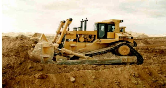
Figure 5: Décapage par BULLEDOZERS
