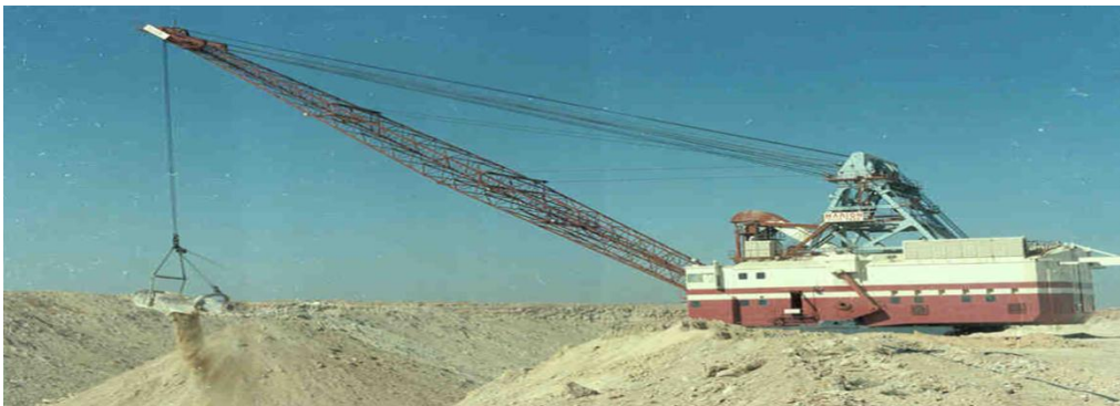
Figure 6: Décapage par Draglines
