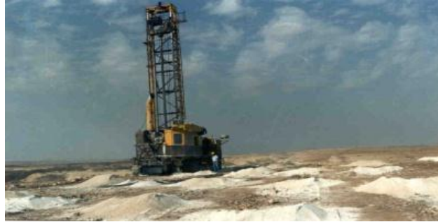
Figure 3: Foration par la sondeuse 45R
