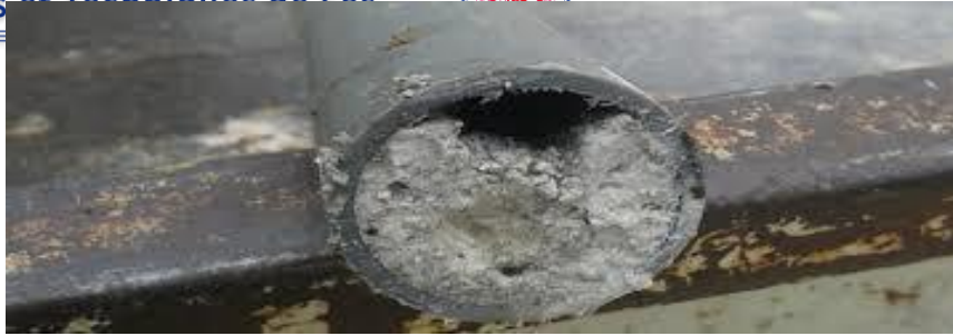
Figure 32 : Bouchage des canalisations
