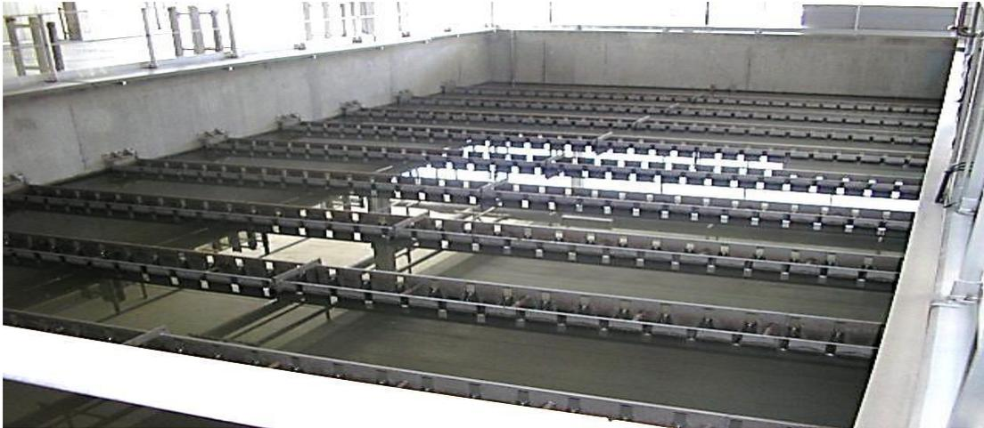
**Figure 6: Processus de décantation de l'eau dans un décanteur lamellaire**
