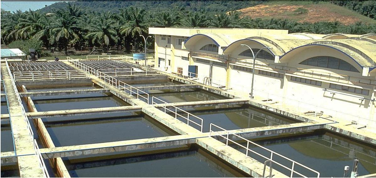
**Figure 7: Filtration de l'eau sur sable**
