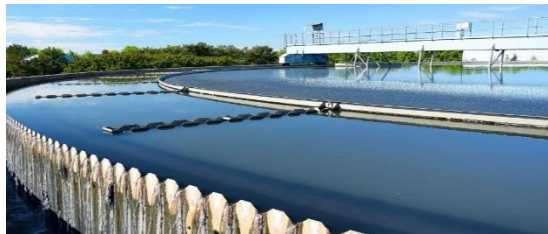
Figure 2: Station de traitement Ain nokbi Fès
