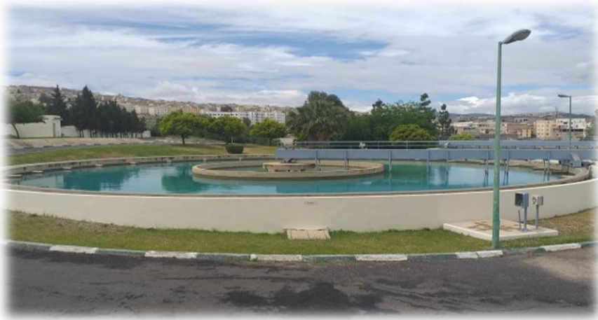
Figure 2 : Décanteur de la station de traitement
