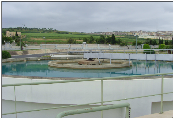
Figure 5 : Opération de décantation dans la station de traitement
