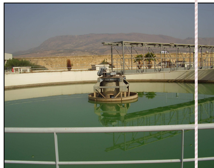
Figure 4 : Opération de débouage dans la station de prétraitement
