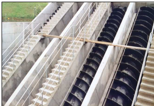
Figure 2 : Opération de relevage dans la station de prétraitement
