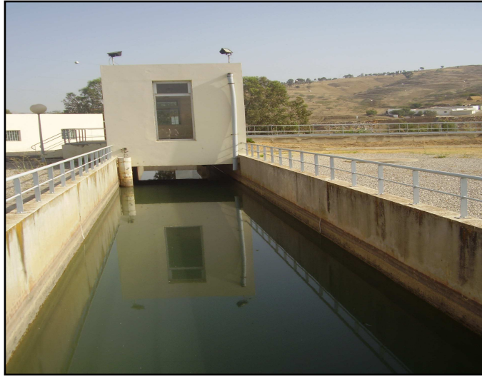
Figure 3 : Opération de dessablage dans la station de prétraitement
