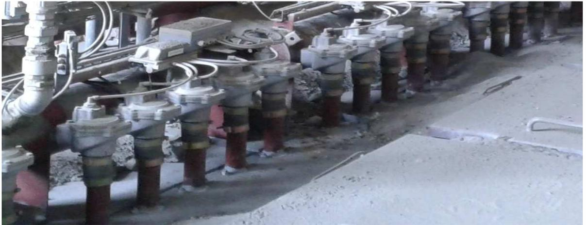
**Figure 24 : Les électrovannes du filtre**
