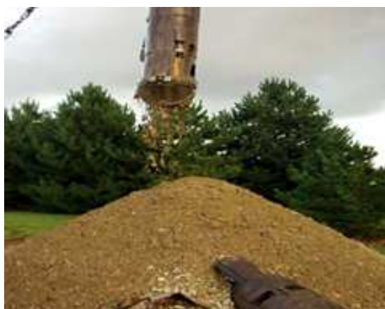
Figure 4: Soupape remonté des débris (cuttings)
