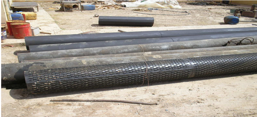
Figure 14: Tubage crépiné et tubage plein
