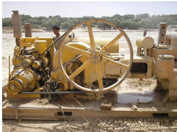
Figure 8: Appareil du recyclage de la boue On a deux types de circulation (fig9.)
