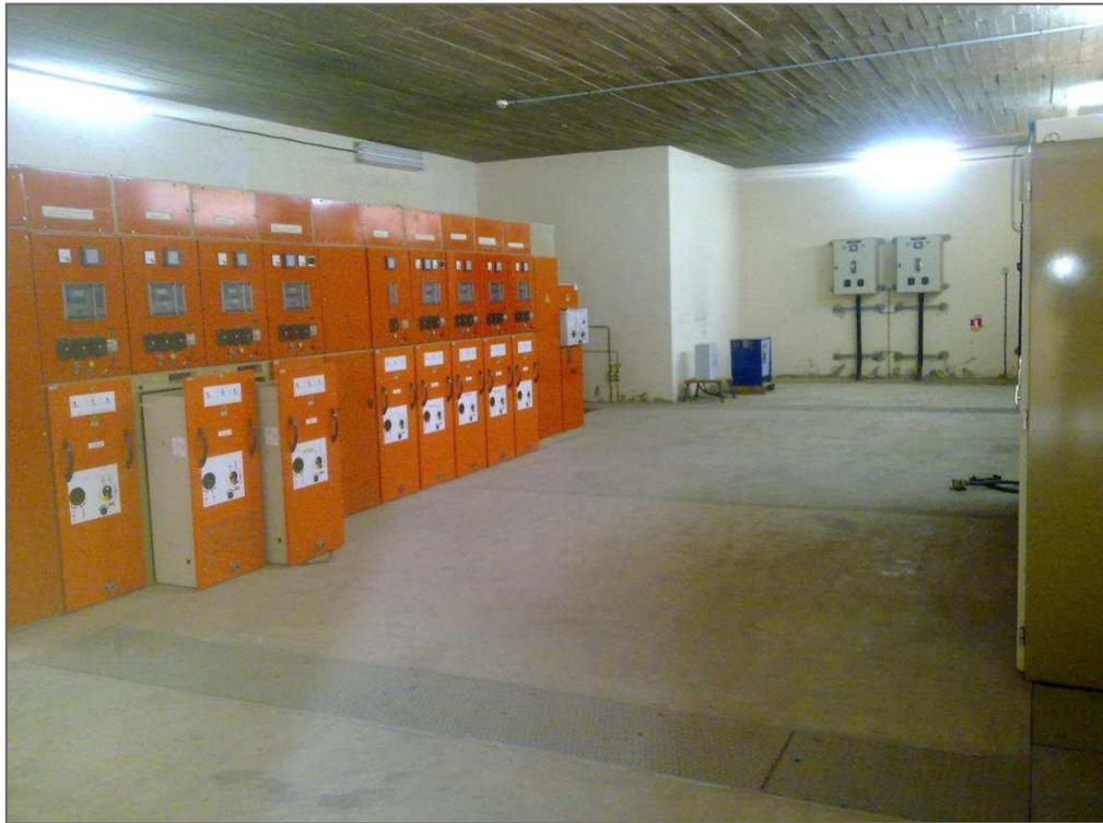
Figure 12 : Des cellules préfabriquées d'un répartiteur de la RAK
