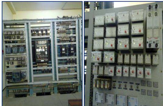
Figure 9 : les relais mécanique et analytique.
