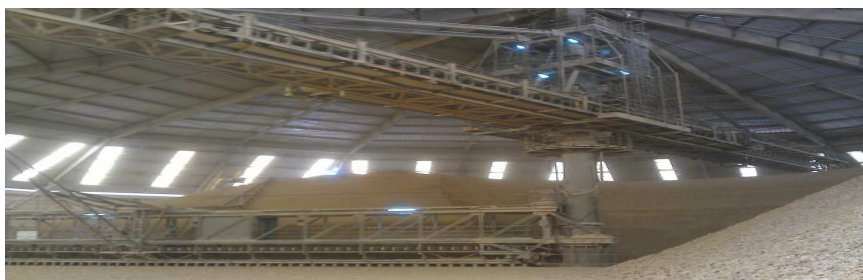
Figure 11: hall pour la pré-homogénéisation
