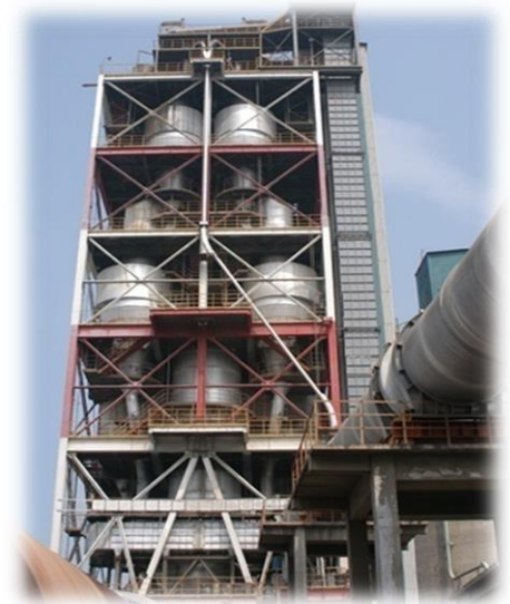
Figure 3 Tour de préchauffage
