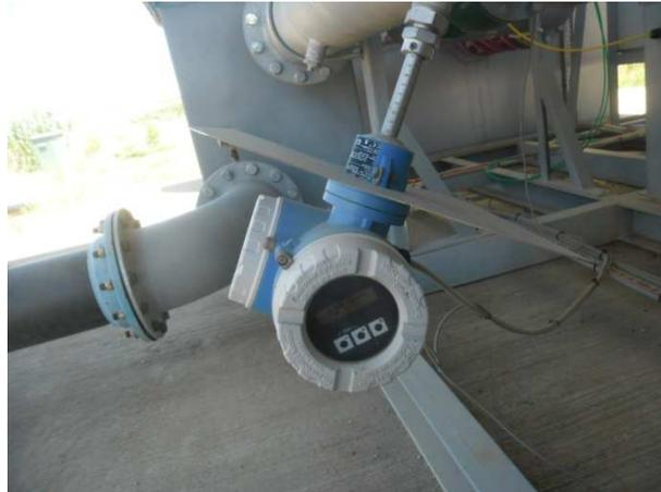
**Photo I.30. Le d bim tre de sortie**
