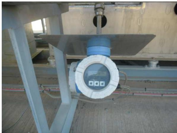
**Photo I.28. Le débitmètre du biogaz entrant à la torchère**
