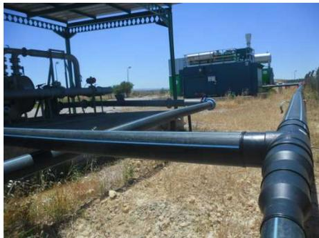
**Photo I.31. Ramification du tube de sortie en deux**
