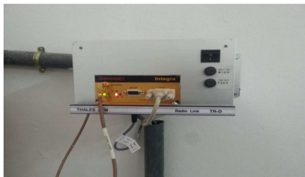
Figure 16: Système Radio Link
