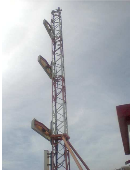
Figure 7: L'antenne du glide-path
