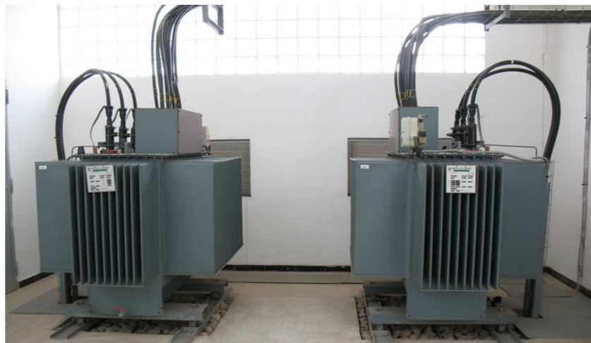
Figure 5: Transformateur triphasé
