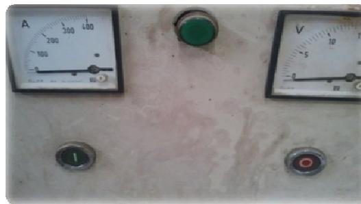
**Image 6 : Redresseur utilisée dans la SADF.**
