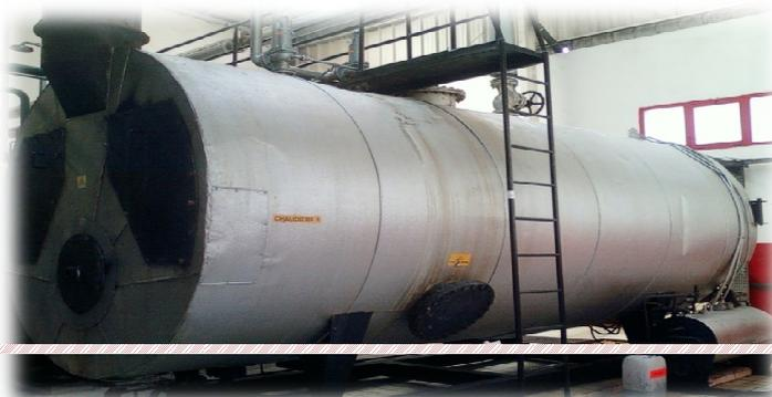
grande flamme s'allume en créant une grande température à l'intérieur de la chaudière qui permet l'évaporation de l'eau.
