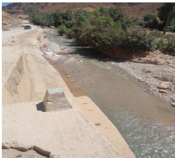
Digue de protection (20/03/2014)
