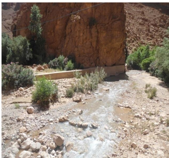
Mur de protection contre l'érosion (20/03/2014)
