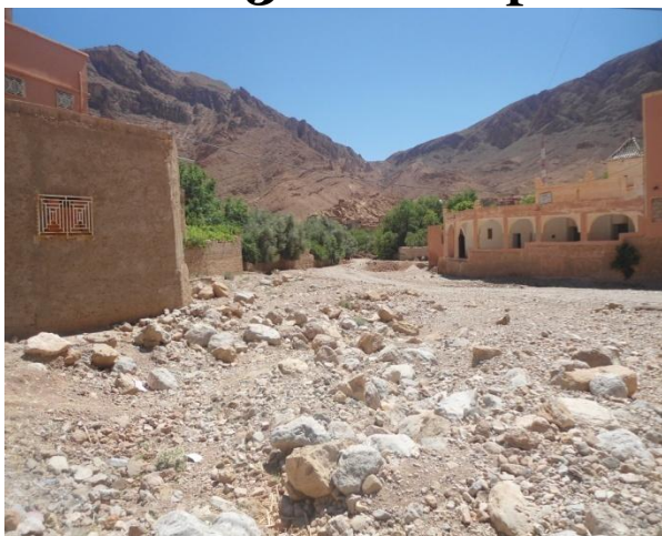
Oued Ougni Tizgui : matériaux de charriage importants (15/11/2013) (ABH GZR)
