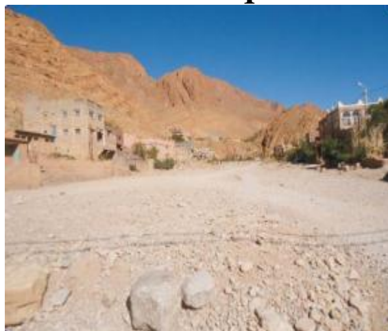
Vue générale de l'oued Ougni Tizgui en amont de la RR703: piste dans le lit et constructions les 2 rives (15/11/2013) (ABH GZR)
