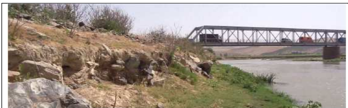
Photo III.1 :L'emplacement de la nouvelle prise d'eau
