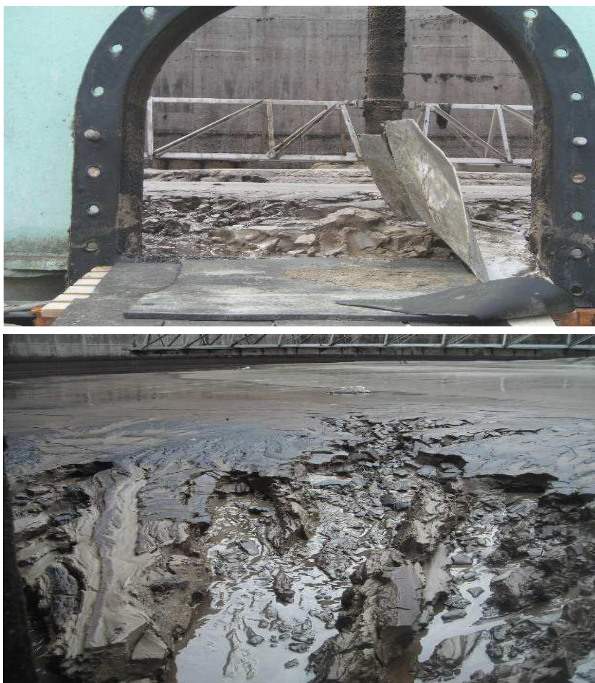
Figure 14 : Opération d'évacuation du gypse
