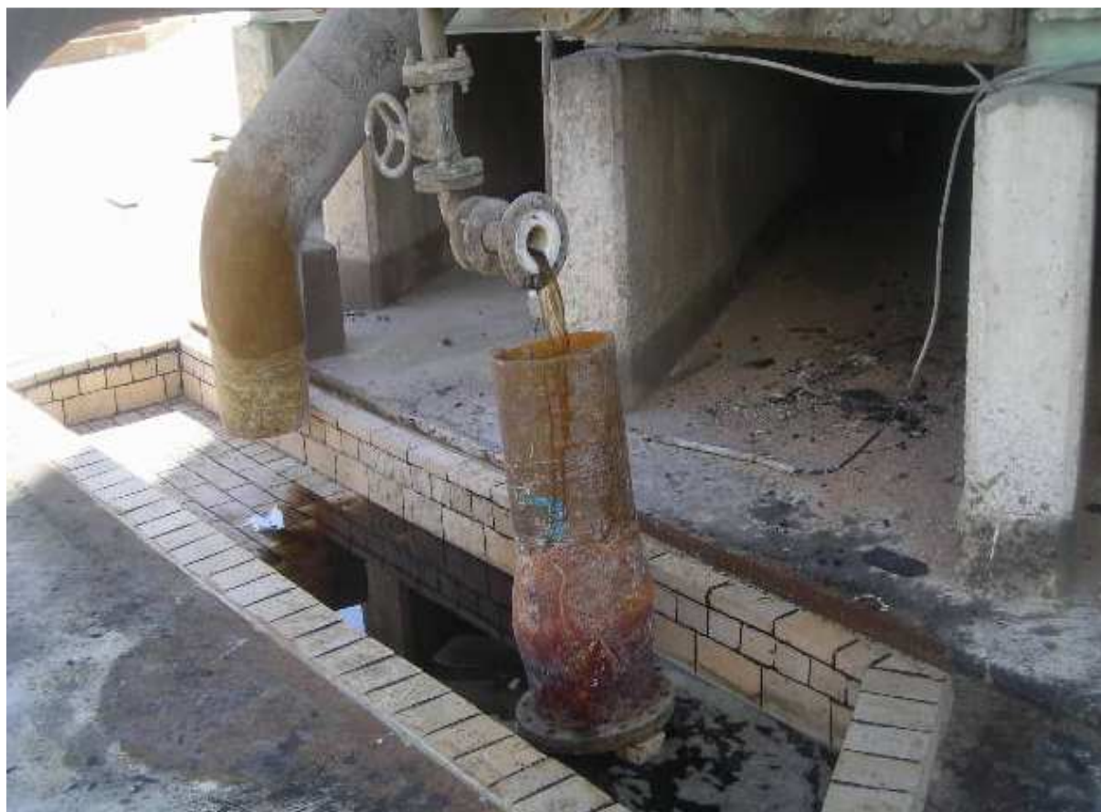
Figure 13 : Technique d'égouttage du gypse
