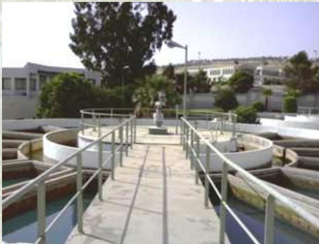
photo 7 : Décanteur à recyclage de boue
