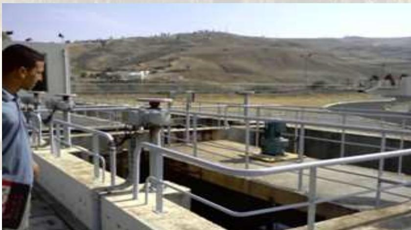
C'est un ouvrage constitué de 4 bacs équipé d'un mélangeur et de 4 vannes départs. Un bac pour mélanger le polymère dans l'eau et les 3 autres pour répartir l'eau entre les déboueurs. A cette étape on fait injecter le polymère le seul réactif utilisé dans la station de prétraitement.
