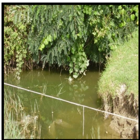
Figure III-11: Oued Sebou au niveau de la prise d'eau
