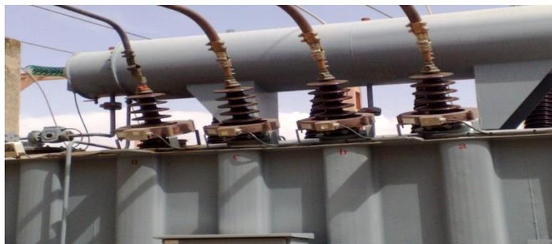
Fig.20: Emplacement des TC sur les pôles secondaires du transformateur HT/MT
