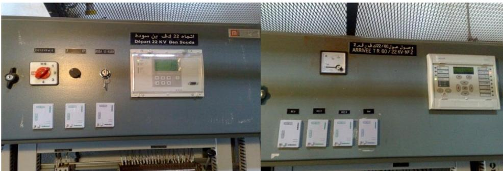
Fig.23: Relais ampérométrique type numérique
