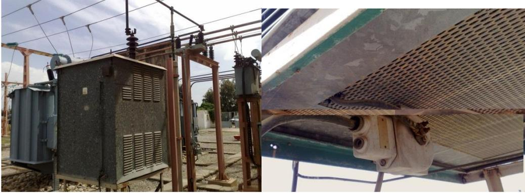
Fig.21: Résistance du neutre 42,5  $\Omega$  et emplacement TC spécial 1/1 A
