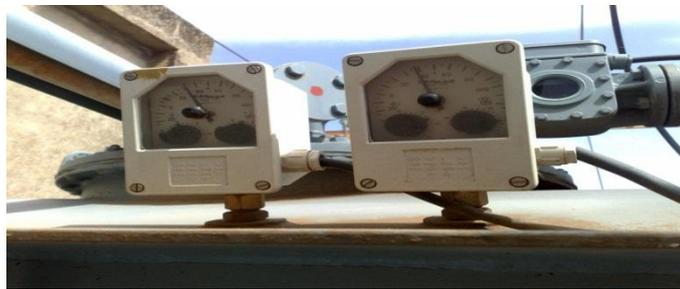
Fig.16: Sondes de température
