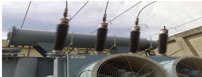
Fig.19: Éclateurs placés sur les pôles HT
