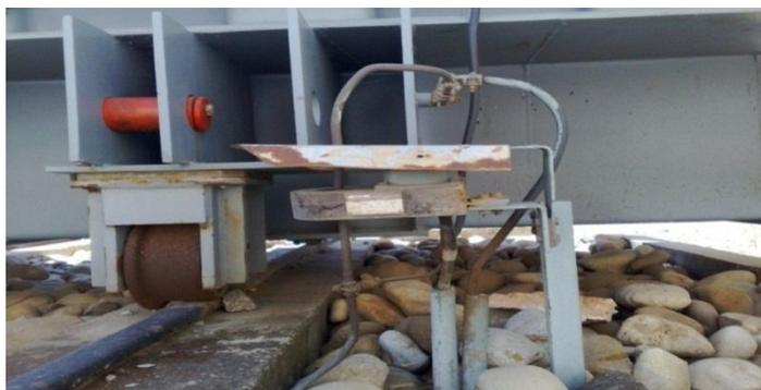
**Fig.18: Protection par masse cuve**
