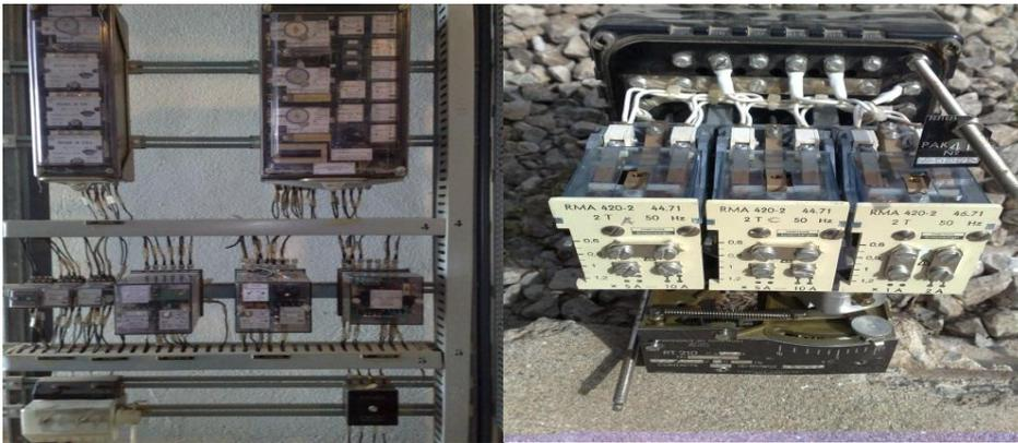
Fig.22: Relais ampérométrique type électromécanique
