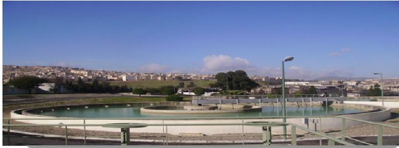
**Figure 5 : Décanteur**
