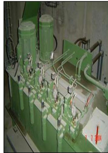
**Figure 18: Centrale hydraulique pompe pour vérins fixes et pour vérins de travail**
