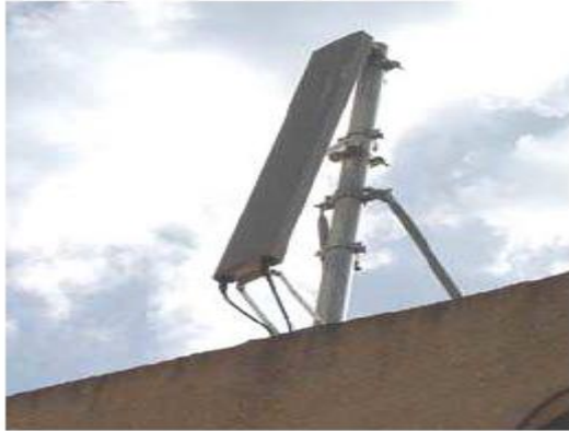
Antenne directionnelle avec tilt positif
