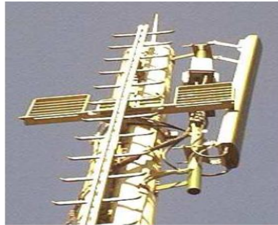
Antenne directionnelle avec tilt négatif
