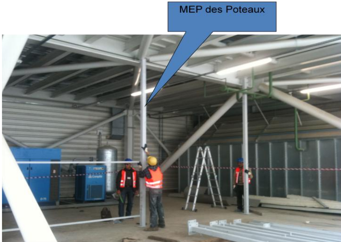
Photo 9 : La première étape de construction de l'atelier de stockage
