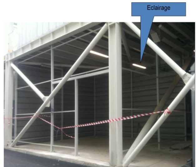
Photo 10 : La mise en place de l'éclairage dans l'atelier
