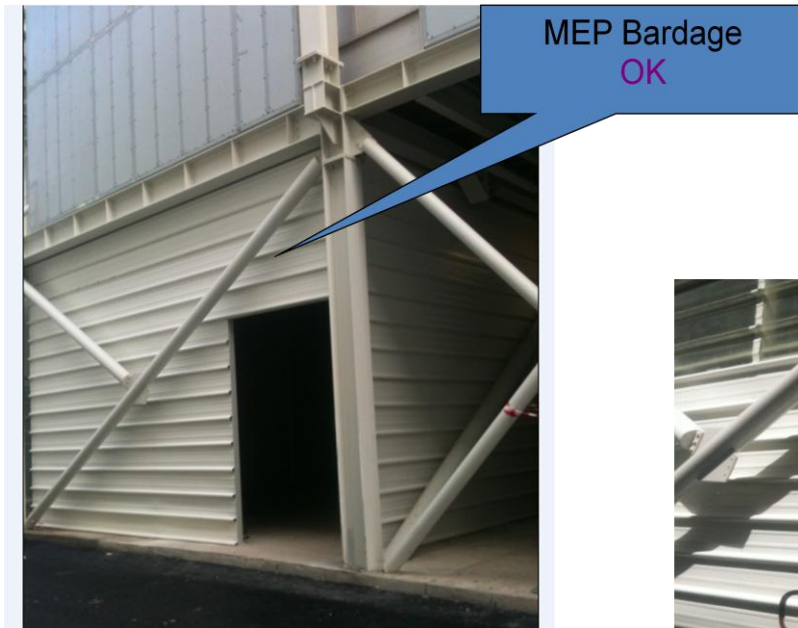
Photo 11 : La mise en place du bardage
