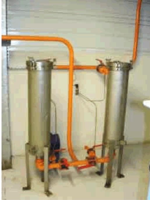
**Figure 9 : Filtration de sécurité avec un filtre poche**
