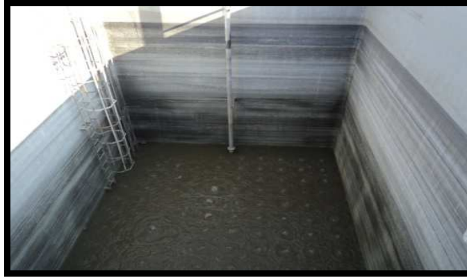
Bassin d'homogénéisation
